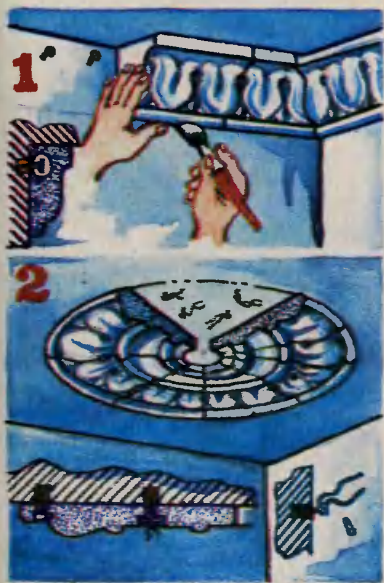
1 — установка деталей карниза; 2 — установка деталей розетки.
